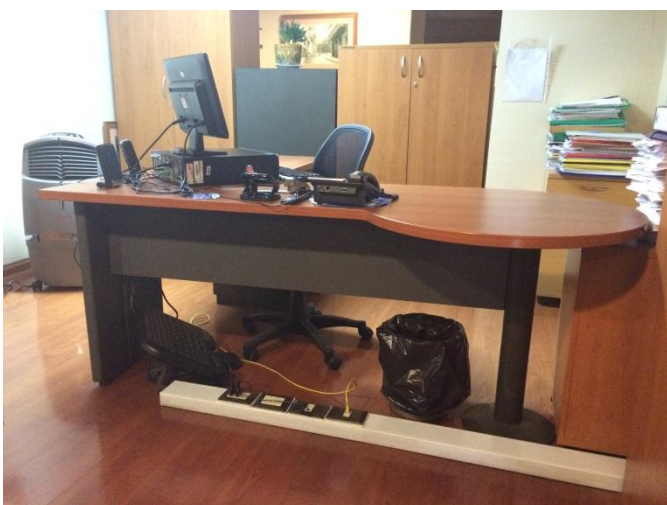
Imagen N°2 Soporte de enchufes a relocar en muro estructural existente
