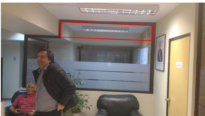
Imagen N°6 Tabiques vidriados a rebajar
