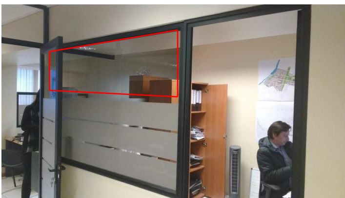
Imagen N°5 Tabiques vidriados a rebajar
