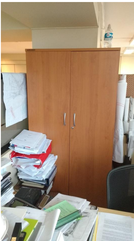
Imagen N°8 Ejemplo de mueble a arristrar a muro estructural existente
